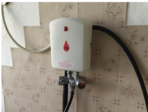
Obrázok 11. Elektrický prietokový ohrievač
