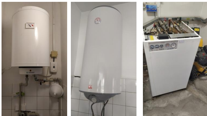
Obrázok 12. Elektrické zásobníkové ohrievače
